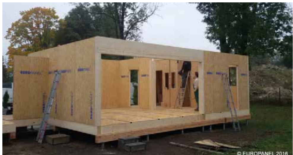
Obr. 4 Výstavba experimentálního domu
